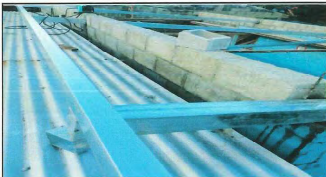
Foto 3: Sustitución de estructura de soporte de metal, por metal, Tubo cuadrado 4x4, chapa 14, AULA 2 DE PREPRIMARIA
