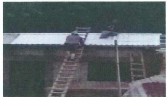
Foto 2. Colocacion de venta de metal
