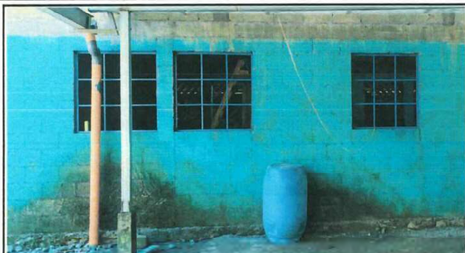
Foto 7: Sustitución e instalacion de ventanas de madera por metal mas vidrio 2.4 x 1.6 METROS , grosor de vidrio 5mm
