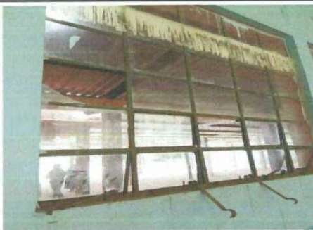
Foto 5. Sustitucion de vidrios de ventana
