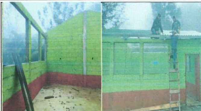
Foto 2: Sustitucion de lamina de baja calidad, por lamina troquelada aluzinc, AULA 1 DE PREPRIMARIA
