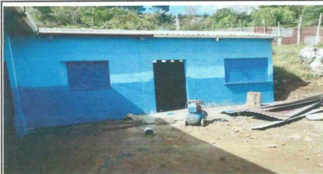
Foto 3. Instalacion de puerta de metal
