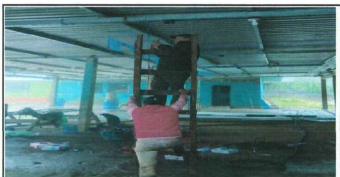
Foto 12: Cambio de sistema eléctrico, sustitucion de cableado electrico y plafoneras.
