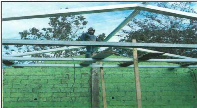
Foto 4: Sustitución de estructura de soporte de madera, por metal, costanera 2x4, chapa 16, AULA 1 DE PREPRIMARIA
