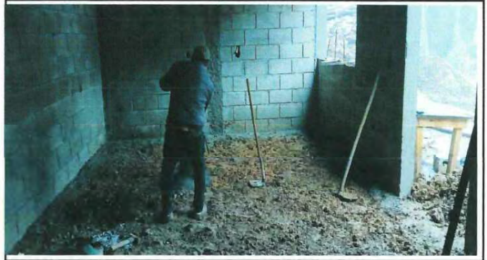
Foto14: Ampliacion y acondicionamiento de Cocina 4x4x3, interior.
