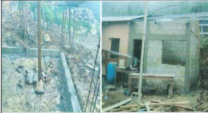
Foto13: Ampliacion y acondicionamiento de Cocina 4x4x3, exterior .
