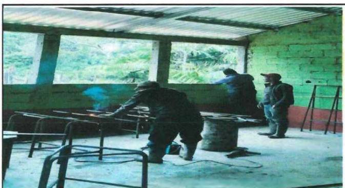
Foto 9: Instalacion de balcones de 2.10 x 1.10 METROS
