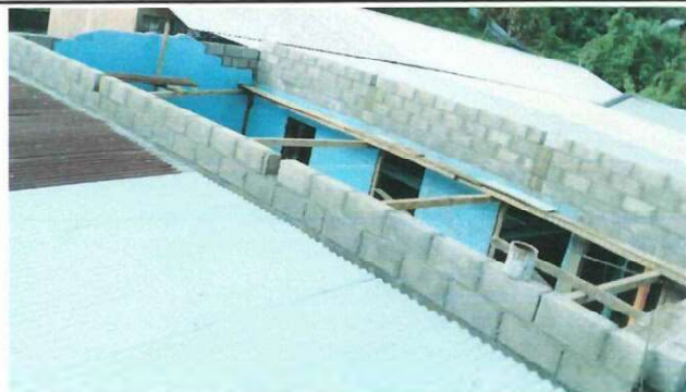
Foto1: Sustitucion de lamina de baja calidad, por lamina troquelada aluzinc, AULA 2 DE PREPRIMARIA
