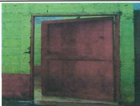
Foto 5: Sustitución e instalacion de puerta de madera por metal, 2.10 x 1 m.
