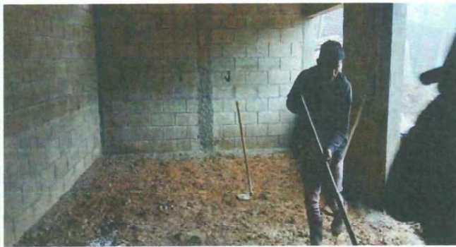
Foto 1. Colocacion de piso de cocina y mesa de concreto
