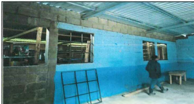
Foto 8: Sustitución e instalacion de ventanas de madera por metal mas vidrio 2.4 x 1.6 METROS , grosor de vidrio 5mm
