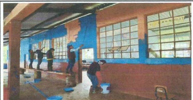
Foto 6. Pintura para el edificio escolar
